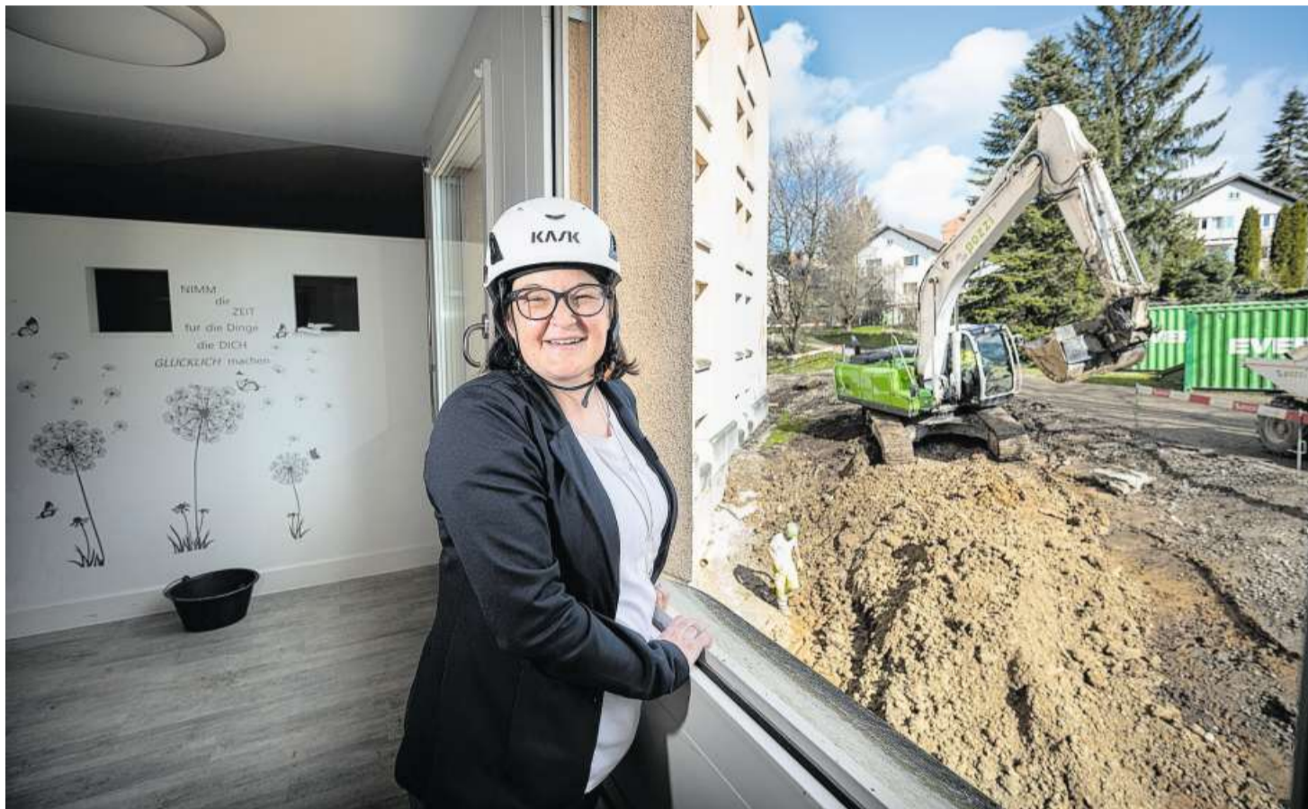
Thurvita-CEO Corinne Dähler im leergeräumten Trakt des «Sonnenhofs», der für die nächsten eineinhalb Jahre eine Baustelle sein wird.
